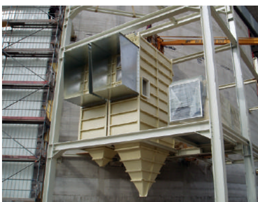
Climatización de un silo de azúcar de 50.000 t con un sistema de colección de polvo para las vías de transporte en la fase del montaje.
