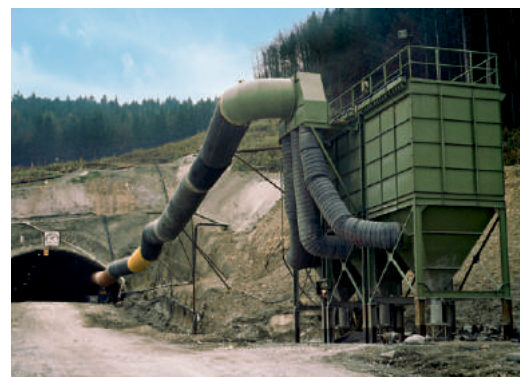
Colección de polvo en la tunelización para crear mejores condiciones de trabajo
