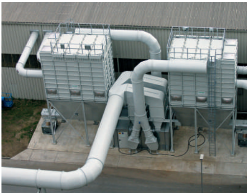
Entstaubung einer Lagerhalle für SDS-Müll.
