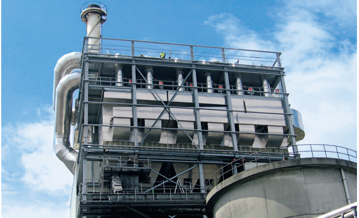
Очистка дымовых газов угольной печи со сжиганием побочных продуктов, с подачей присадок и утилизацией летучей пыли. Общая производительность: 165 000 м³/ч при рабочей температуре 160 °С.
