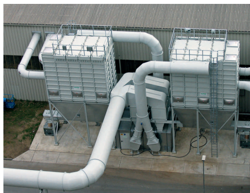
Аспирация мусорной свалки на цементном заводе
