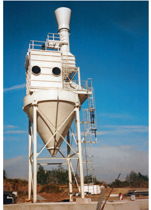
Пылеочистка дробилки на известняковом карьере
