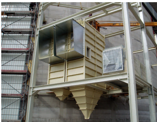
Система кондиционирования силоса для сахара ёмкость 50.000 т с системой пылеочистки путей транспортировки на стадии монтажа.
