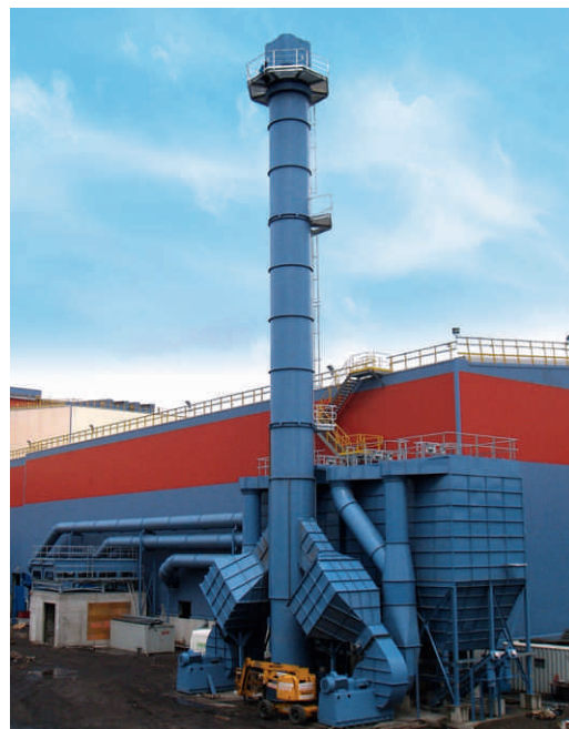
Линия горячего шлифования слябов в Бельгии, объемный расход 300.000 м³/ч.
