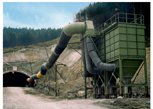
Обеспыливание в тоннелестроении
